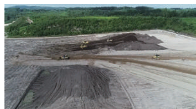
ドローンで撮影した施工中の様子
